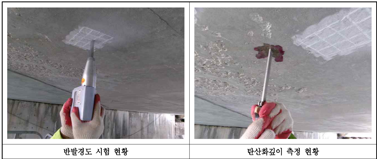
【사진 6.4.1】 콘크리트 내구성조사 현황
