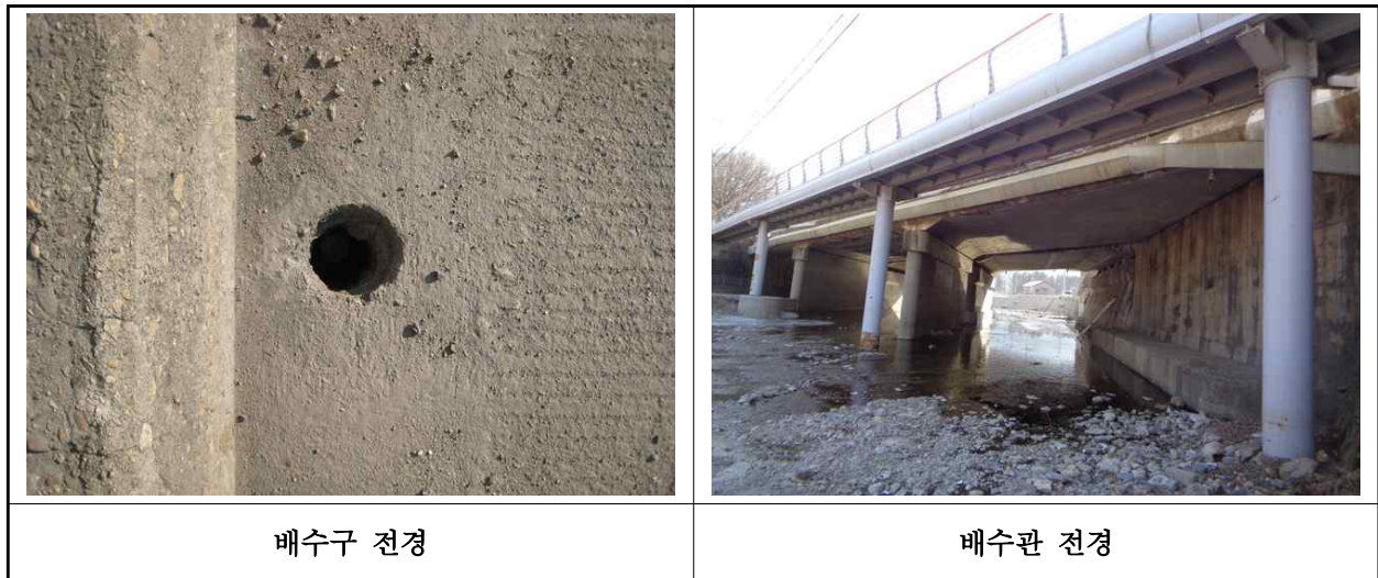
【사진 6.3.17】 배수시설 전경
