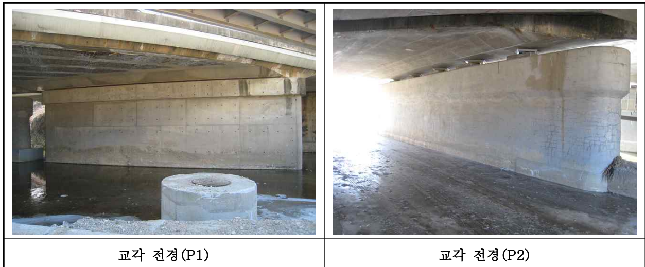
【사진 6.3.6】 교각 전경
