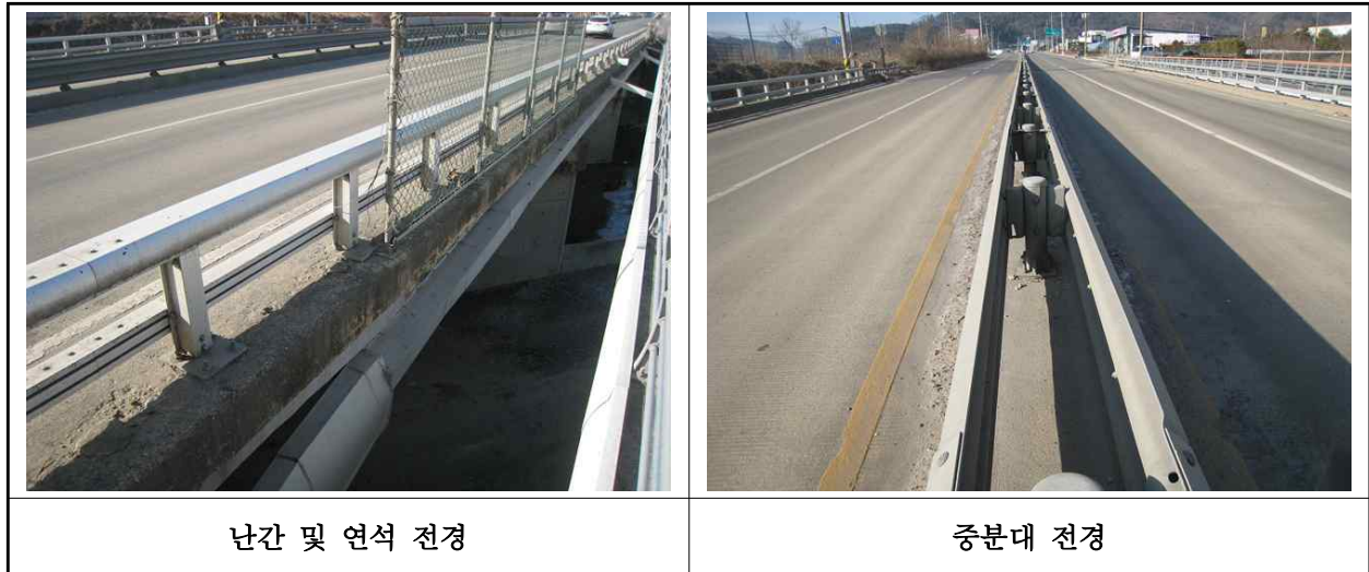
【사진 6.3.19】 난간 및 연석 전경
