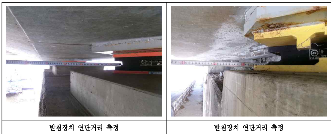
【사진 6.3.10】 교량받침장치 연단거리측정
