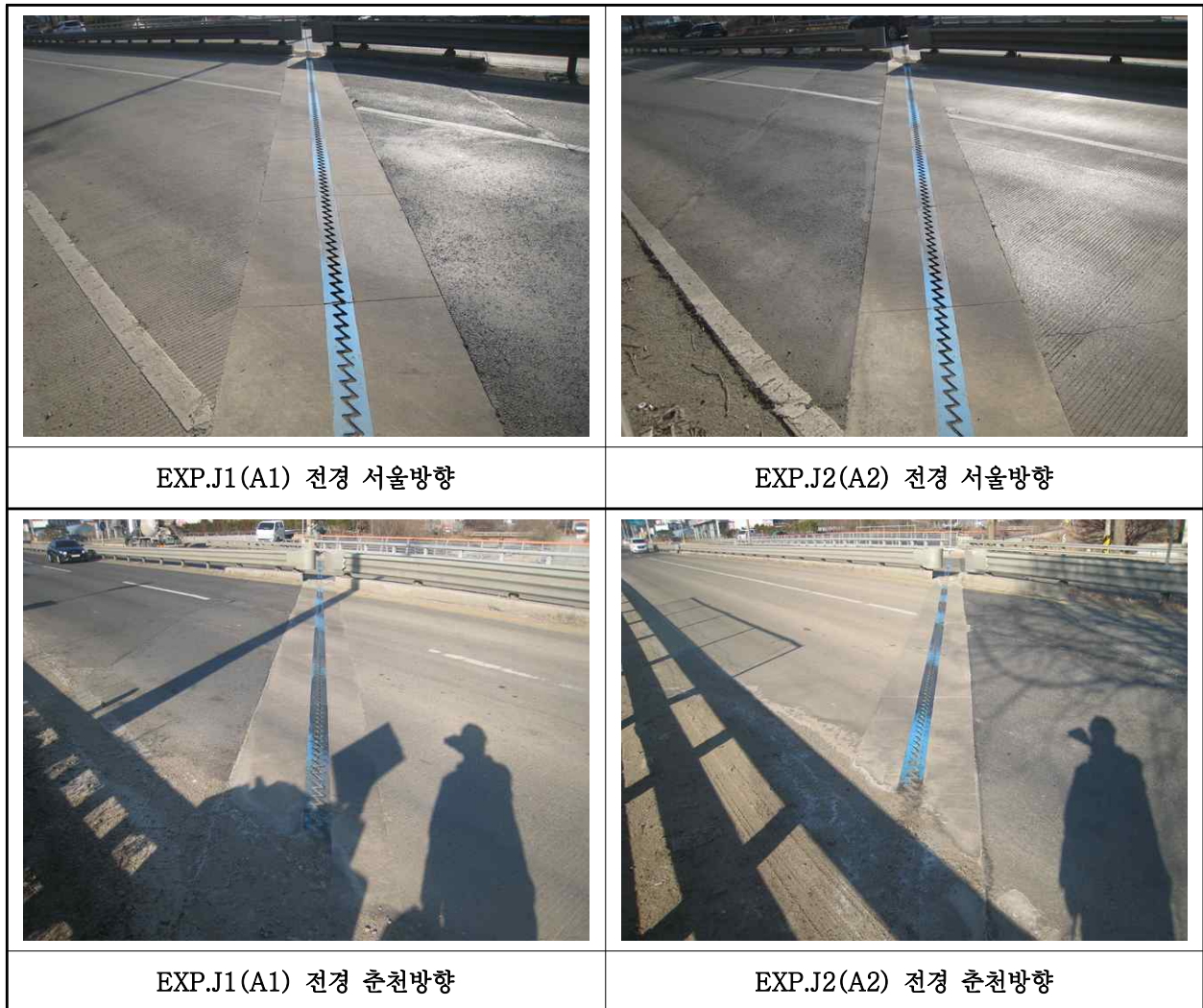
【사진 6.3.12】 신축이음장치 전경
